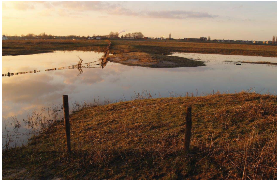
Een zeldzaam fraai overblijfsel van bekribbing uit de 1e fase van de normalisatie bij Wamel: een houten krib aangelegd ter afdamming van een Waalgeul.
