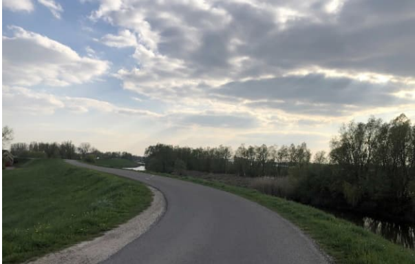
Afbeelding 8: Bestaande strang Dreumel vanaf de winterdijk
