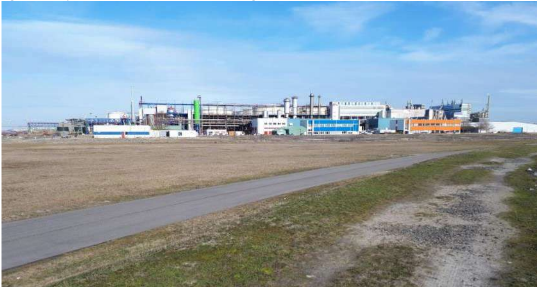
Figuur 6-6 Geplande locatie Evolution terminals BV gezien vanuit het zuiden
