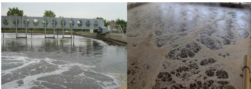
Afbeelding 2.4. Overeenkomstige beluchting van een biologische zuivering bij een RWZI (links) en IWZI (rechts) (Bron: RIVM)
